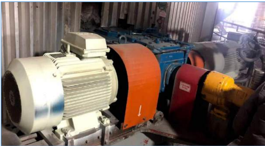
鸳鸯湖电厂现场改造图
