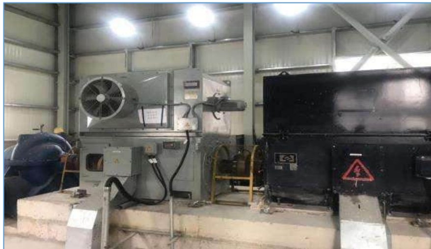
消白循环泵改造现场图
