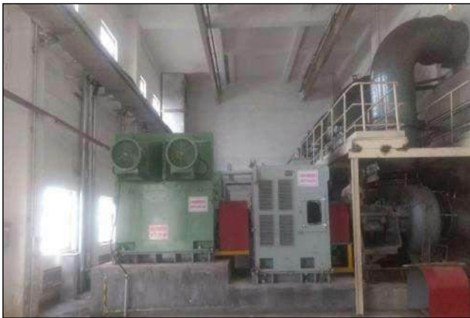
马鞍山项目现场改造图片
