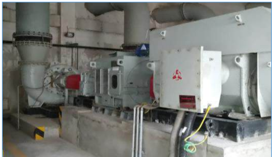
浆液循环泵改造现场图
