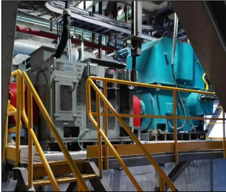
天津大港发电厂造现场图片
