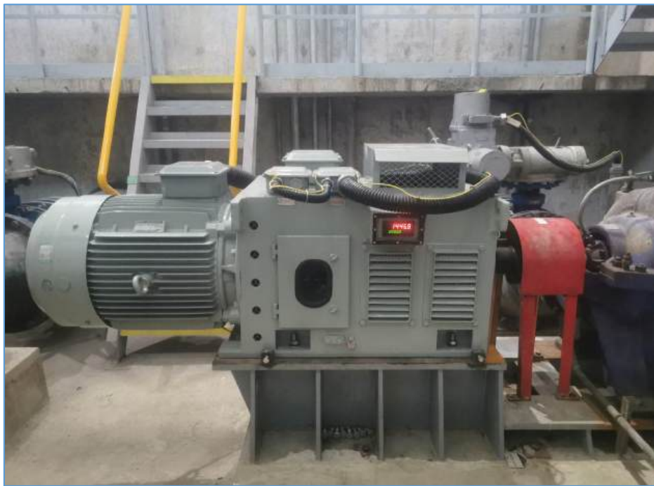
轴向一体化永磁电机+绕组永磁现场图
